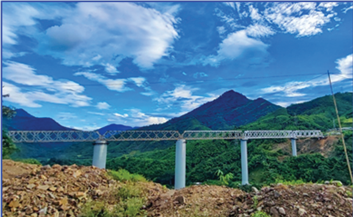
खोंगसांग स्टेशन से नोनी स्टेशन, मणिपुर के बीच इरिंग नदी पर रेलवे ब्रिज नंबर 130 Railway Bridge no.130 over river Iring in between Khongsang Station to Noney Station, Manipur
