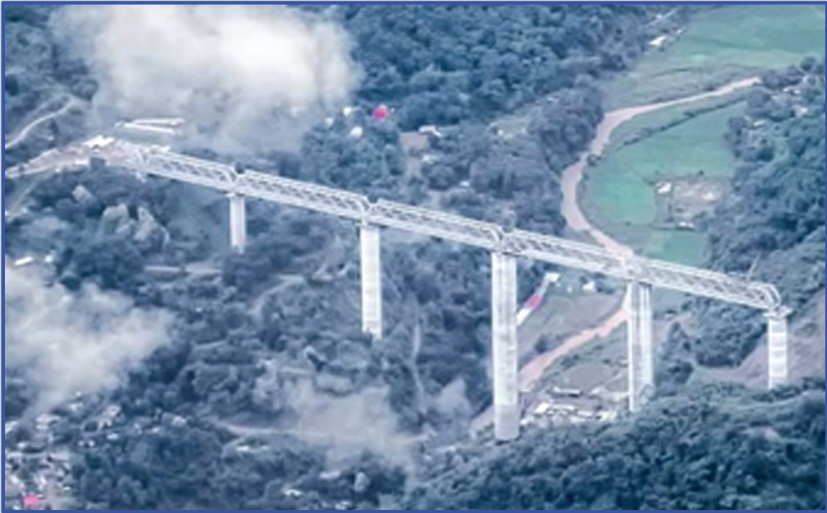
खोंगसांग स्टेशन से नोनी स्टेशन, मणिपुर के बीच इरिंग नदी पर रेलवे ब्रिज नंबर 164 Railway Bridge no.164 over river Iring in between Khongsang Station to Noney Station, Manipur
