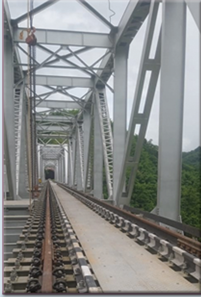
बैराबी - सैरांग, मिजोरम के बीच रेलवे ब्रिज नंबर 64 Railway Bridge no.64 between Bairabi - Sairang, Mizoram
