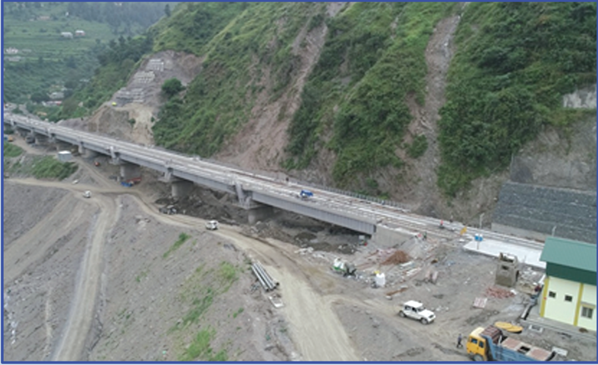
संगलदान खंड पर यूएसबीआरएल परियोजना के तहत, जम्मू और कश्मीर जिले के रामबन में पुल नंबर 2 Bridge no.2 at Jammu & Kashmir in district Ramban, under the USBRL project at Sangaldan section,
